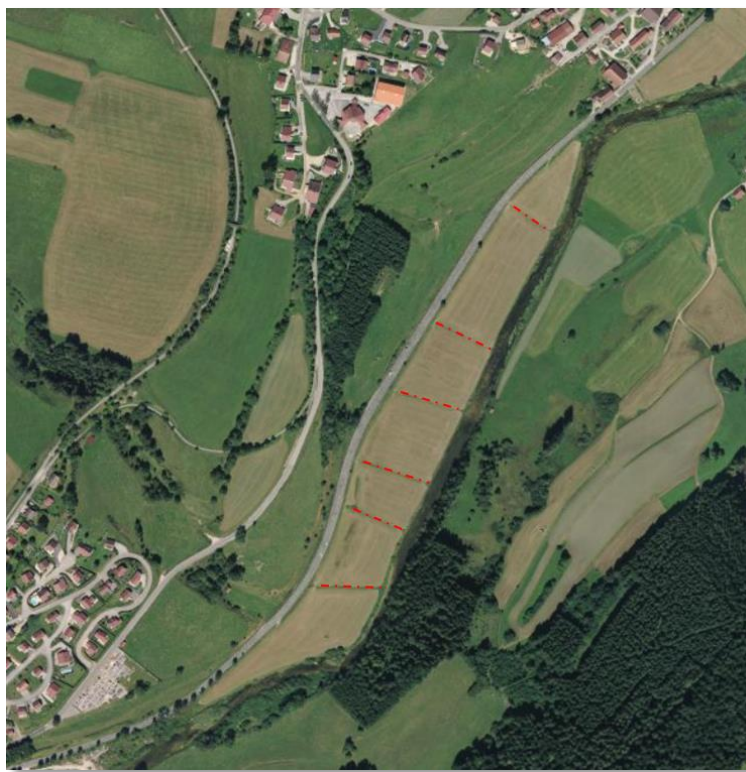
Figure 24: Drains localisés en amont de Ville-du-Pont
